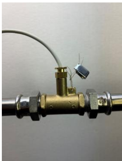
Figure 6 - Meter sealing done by the installer Rysunek 3 – Plomba na ciepłomierzu założona przez instalatora
